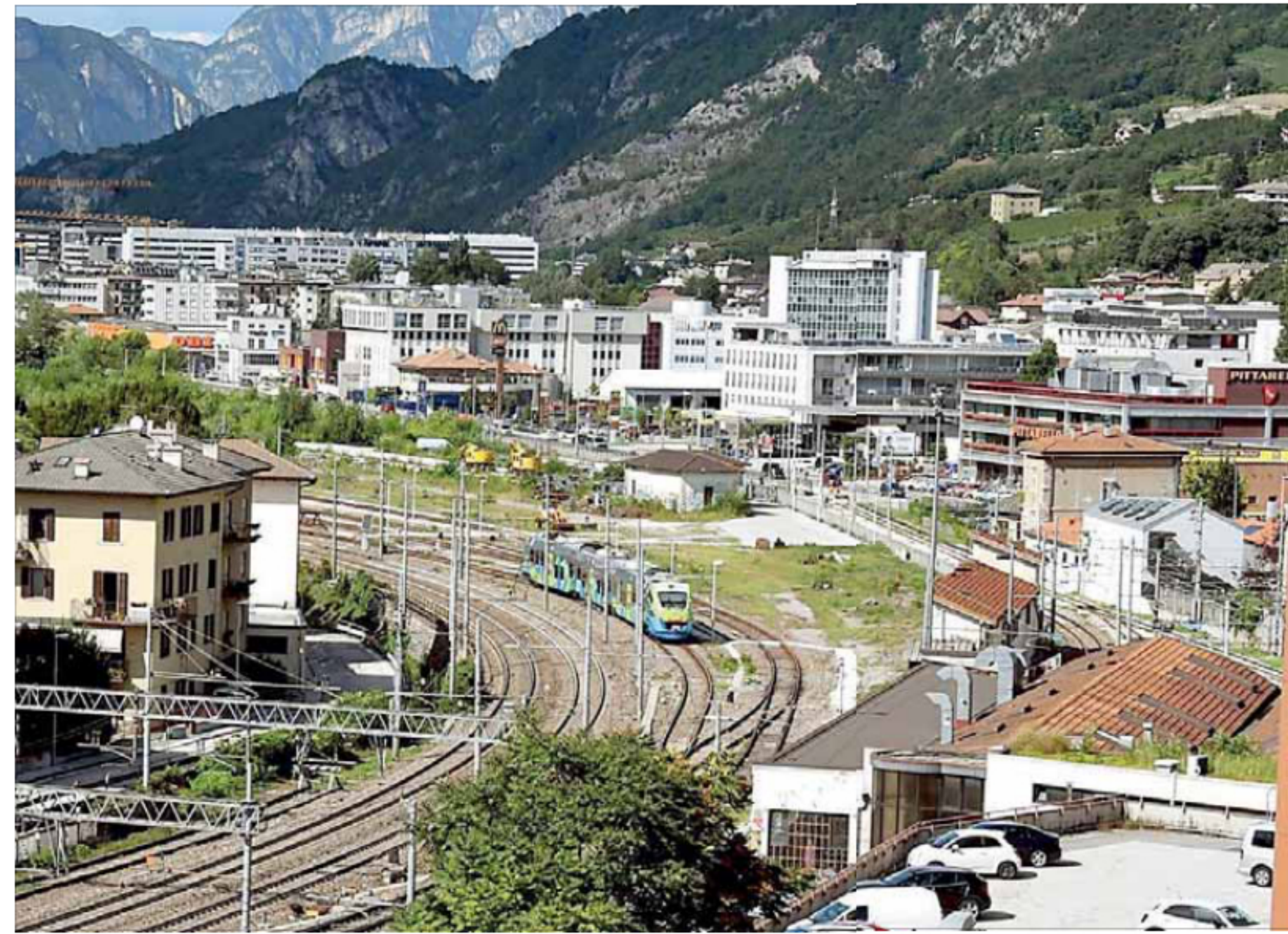
Lo snodo strategico dell'ex Scalo Filzi. Sulla destra, la zona di via Brennero dove alcuni edifici saranno abbattuti (foto Pedrotti)
